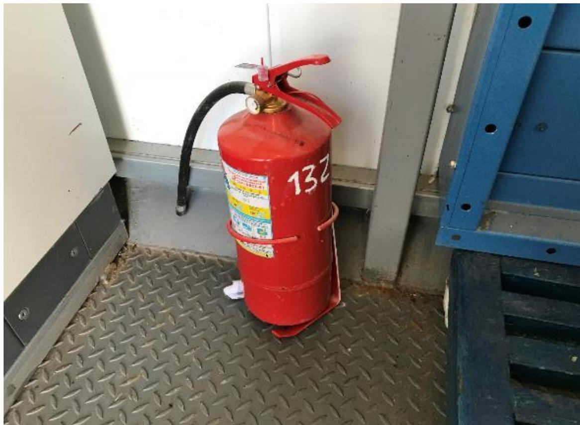
На полу расположен огнетушитель ОП – 5. Эксплуатируется с нарушением. Не закреплен кронштейн держатель.
